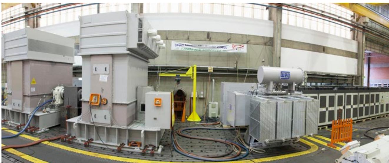
Teste combinado (conjunto de manobra de entrada MT + transformador defasador + inversor de frequência MT + motor MT).
